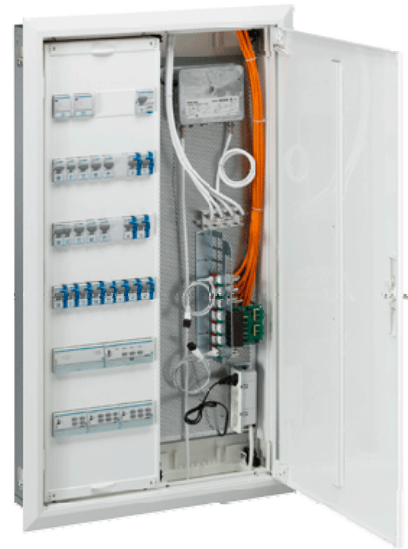
Abb. 6: Bild eines Verteilers für ein Wohnobjekt
